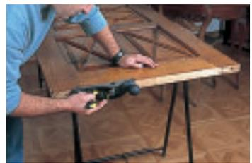
**3. Rectifier le bas de la porte. Selon la hauteur à enlever : scier, raboter ou poncer jusqu'au tracé.**
